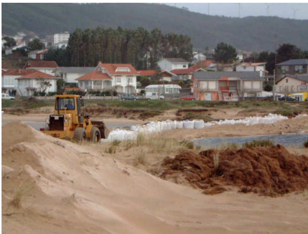
Maquinaria acondicionando el dique de aislamiento de la laguna de A Frouxeira, Valdoviño, con arena procedente de la propia duna
